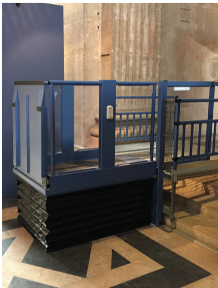
Oprit vormt een afrijbeveiliging van 1,1 m hoogte boven het platform in lijn met de railing
