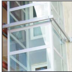
Krans om de lift voor extra stabiliteit
